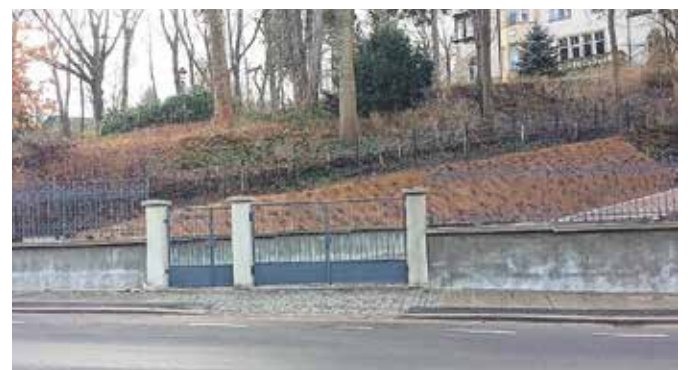
Toranlage und Teil der Stützmauer nach Fertigstellung Foto: Amt für Zentrales Immobilienmanagement
