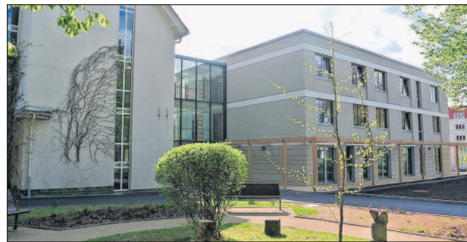
Außenansicht des neuen Erweiterungsbau der Klinik für Psychiatrie, Psychotherapie und Psychosomatik des Glauchauer Klinikums Fotos (2): Rudolf Virchow Klinikum Glauchau
